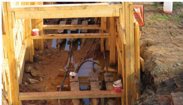
Рис. 5. Фотография соединений, используемых для подключения отдельных секций кабеля в полевых условиях.
